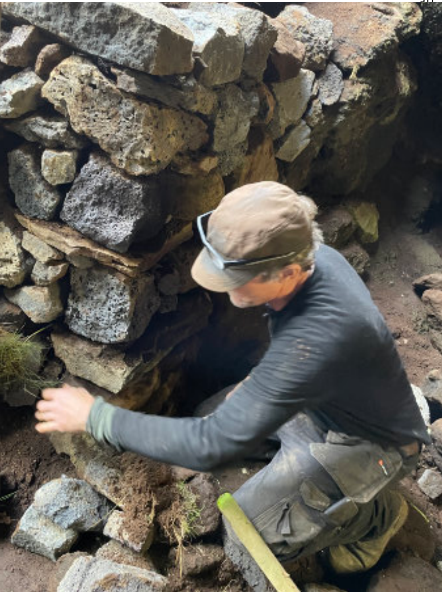
En grotta har använts på gården i olika syften, senast som matkällare. Den renoveras nu med vulkansten av en skicklig kallmurare. Vi fick lära oss grunderna i en workshop.
